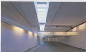
Lichtschlitz Tiefgarage Light shaft, underground car park
