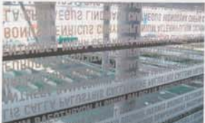
Sonnenschutzbedrückung Kern B Text on the sun awnings, Hub B
